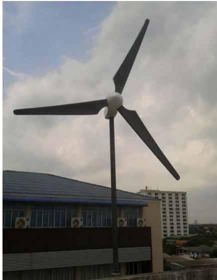
ภาพที่ 3.38 การประกอบและติดตั้งกังหันลม
