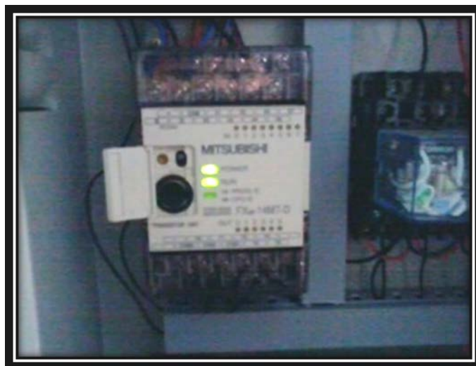
รูปที่ ค.5 การ โยกสวิตช์ตัว PLC
